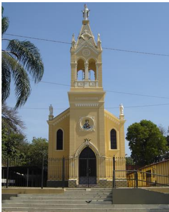
Figura 2- 10. Igreja Nossa Senhora do Socorro
